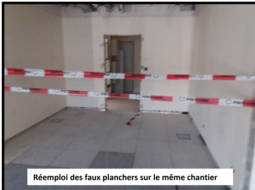
Démantèlement soigné des faux plafonds pour réemploi par le client sur le même chantier
